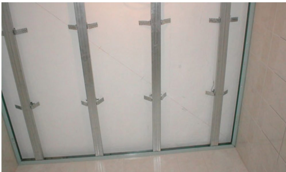
Металлическая обрешетка для монтажа пластиковых панелей на потолок в ванной.
